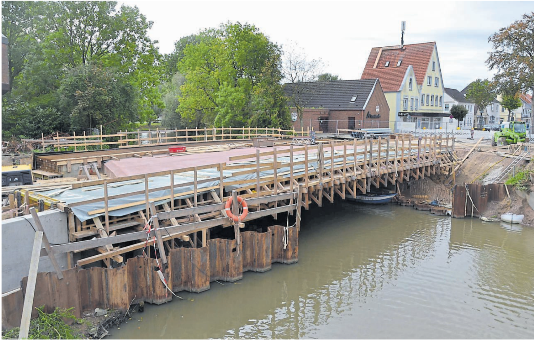
Die Brücke über die Braake wird erst Ende des Jahres fertig und nicht wie ursprünglich geplant Ende Oktober.
