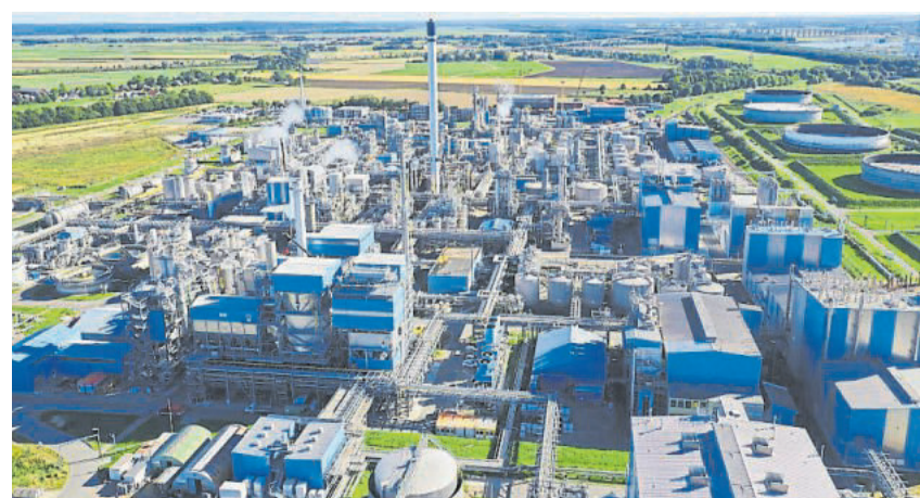
Das Elbeforum und das Freizeitbad bekommen bereits seit einigen Jahren Wärme von Sasol geliefert.
