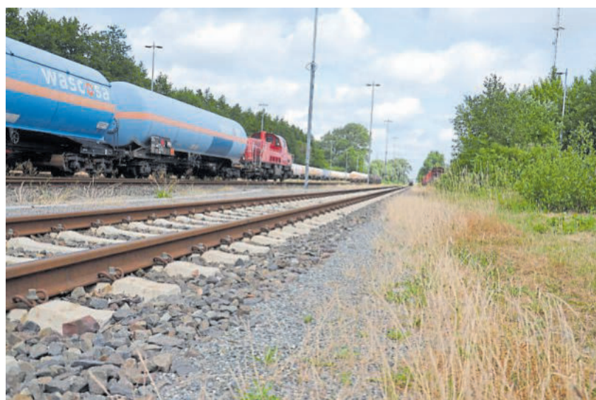
Bislang gibt es auf der Trasse Brunsbüttel-Itzehoe nur ein Bahngleis. Foto: Becke
